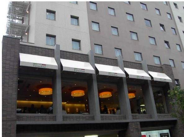
窓の外で遮光する事により、冷房負荷の大幅な低減に繋がります。
